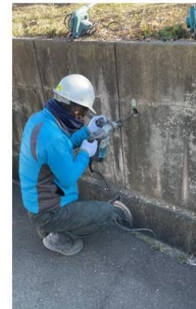
水抜き穴清掃 ハンマドリル振動押し込み
