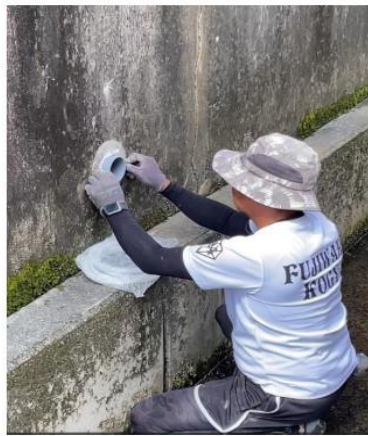
塩ビ管の周りをスポンジで仮止めする
