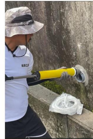
隙間に注入する
