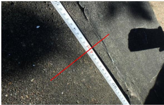
付近状況写真 16 擁壁高さ確認②
