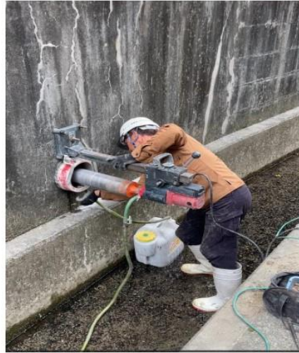
コア抜き110パイ ダイヤモンドソーでゆっくり穴を開けるため 亀裂ははいらない
