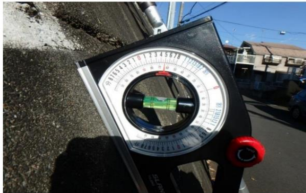
付近状況写真 17 擁壁傾斜角確認①
