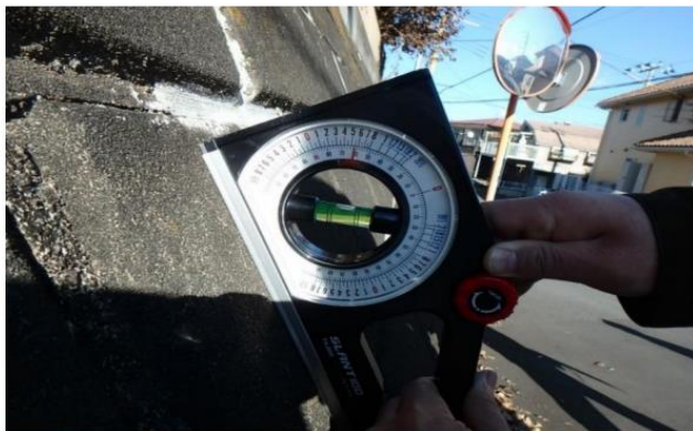
付近状況写真 18 擁壁傾斜角確認②
